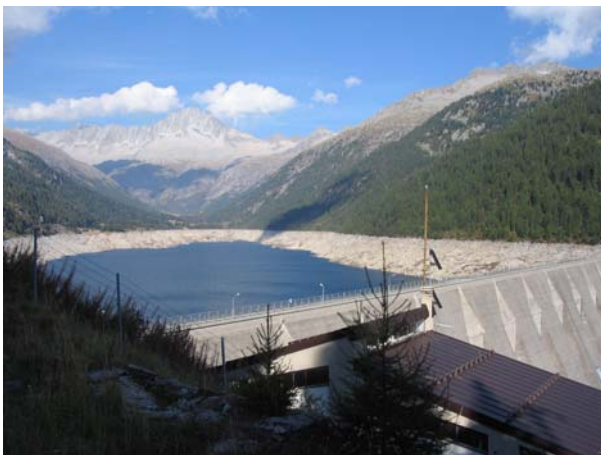
Fig. 25. Diga di Bissina in val Daone
