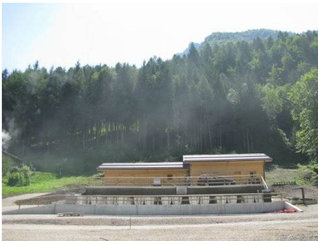
Fig. 30. Vista esterna dell'incubatoio di valle a Bolbeno
